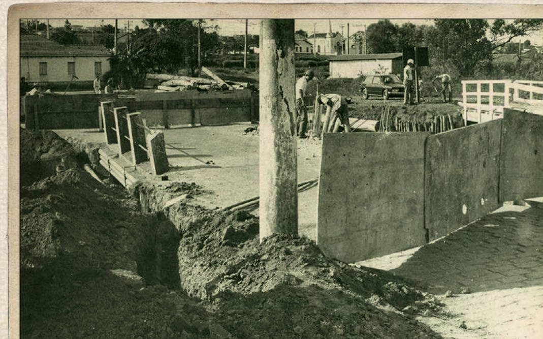
Reconstrução de Ponte sobre o Ribeirão Jacuba, situada entre Vila São Francisco e Vila Real, durante 1ª gestão "José Denada", atualmente denominada Osmar Debelin (ao fundo e à direita, vista dos antigos "Armazém da Estação Jacuba" e "Templo Presbiteriano"). Distrito de Hortolândia-SP. Datada entre 1963-1968. Autor Desconhecido. Coleção "Memória Fotográfica", Arquivo Histórico da Associação Pró-Memória de Sumaré/Centro de Memória "Thomas Dídona", Sumaré-SP.
